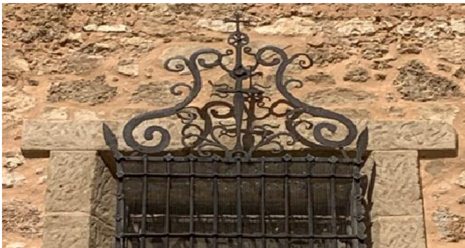
Fig. nº 64. Reja en la Iglesia de Socuéllamos con Cruz de Santiago.
