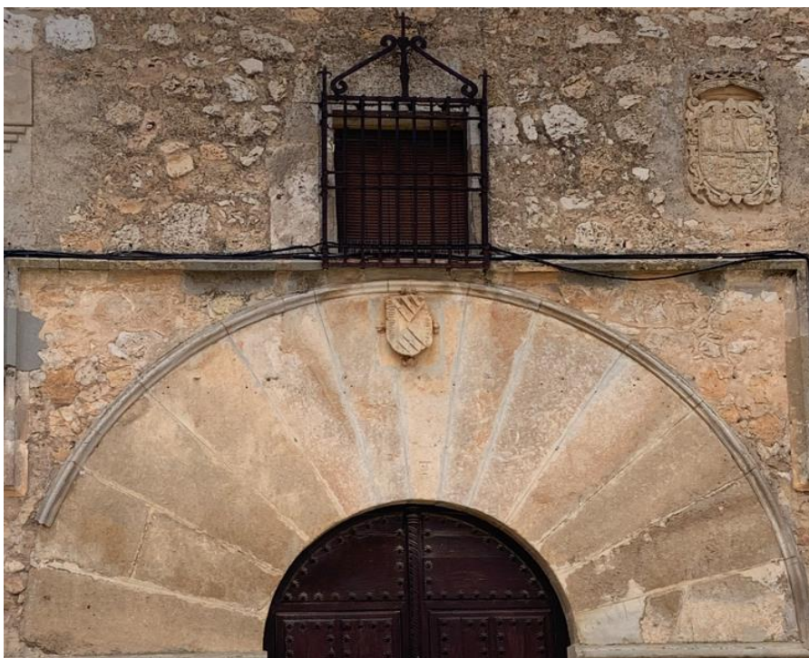
Fig. nº 164. Íñigo López de Mendoza y Suárez de Figueroa, I Conde de Tendilla: escudo del último tercio del siglo XV, en la parte superior de las dovelas jónicas de la puerta, Casa de la Encomienda de Socuéllamos.
