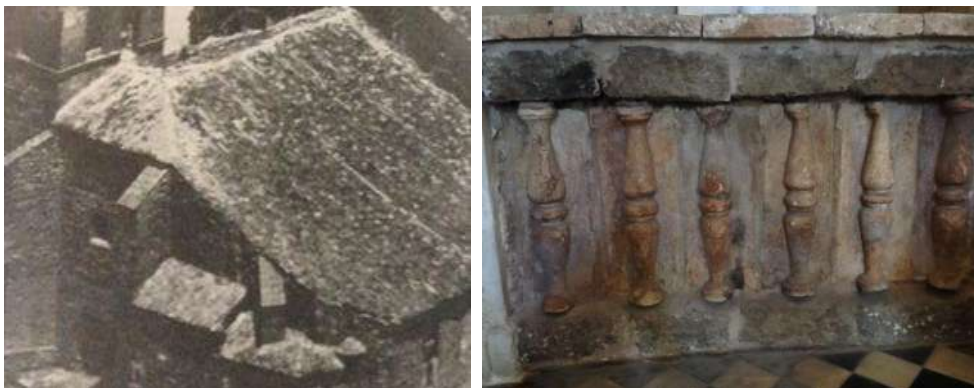
Figs. 33 y 34. Antigua Iglesia de Santiago, junto a la primera casa de Clement Pérez de Rus y Castillo. Elementos constructivos más antiguos en la Iglesia de Santiago, en antigua Capilla Mayor.
