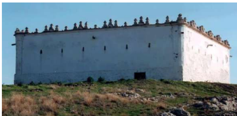
Fig. nº 92. Castillo-Torreón de Rus, restaurado.
