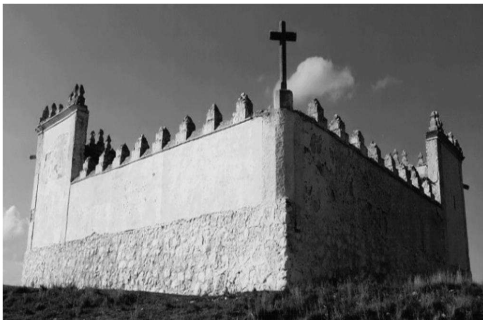
Fig. nº 23. Castillo-atalaya de Rus. Existen restos de mampostería arábica en la construcción de los muros.
