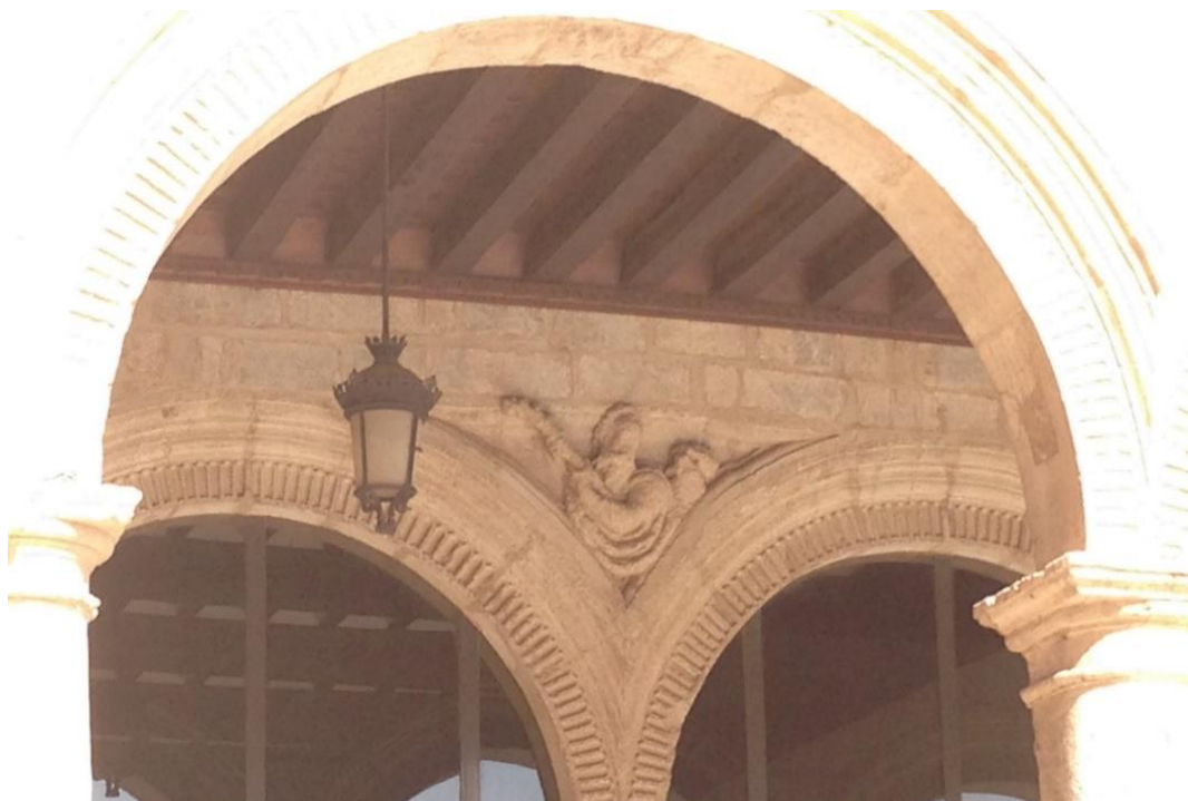
Fig. nº 31. Detalle de los soportales del Ayuntamiento. Siglo XVI.
