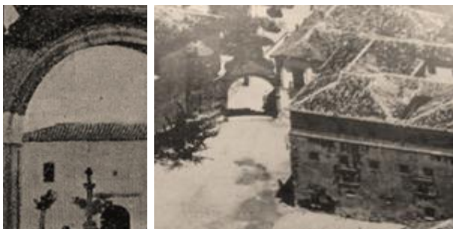
Fig. nº 95. Antigua Plaza de la Picota con el Pósito y Carnicerías (tres plantas).
