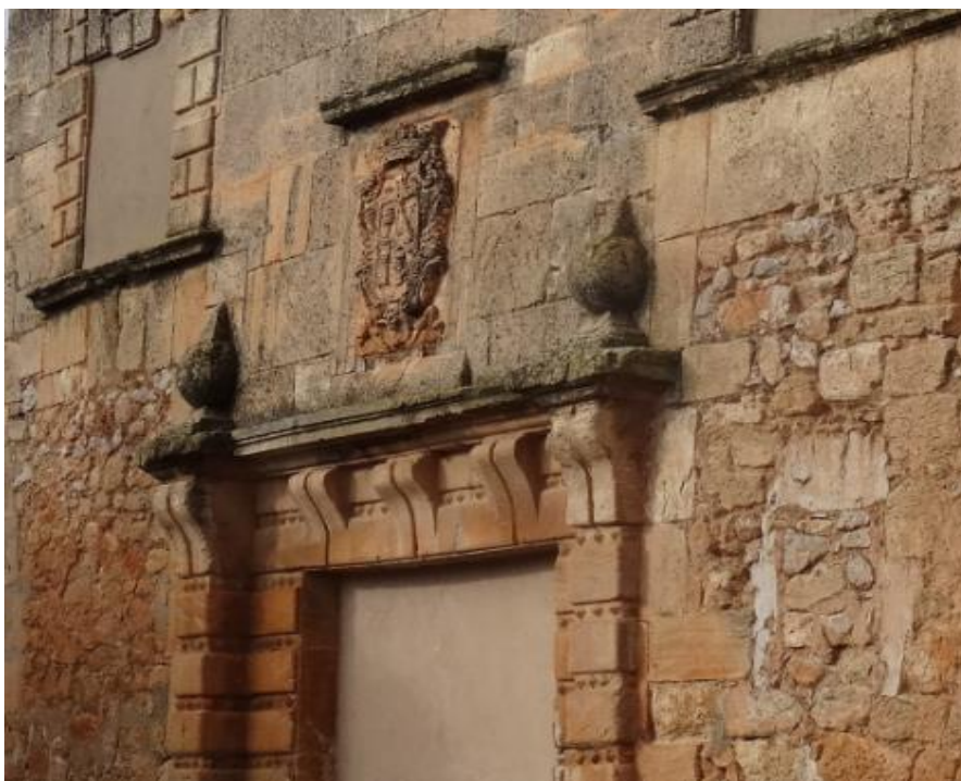
Fig. nº 86. Casa-palacio de los Galindo-Tébar-Piquinotti. Fachada de piedra vista y de sillería.
