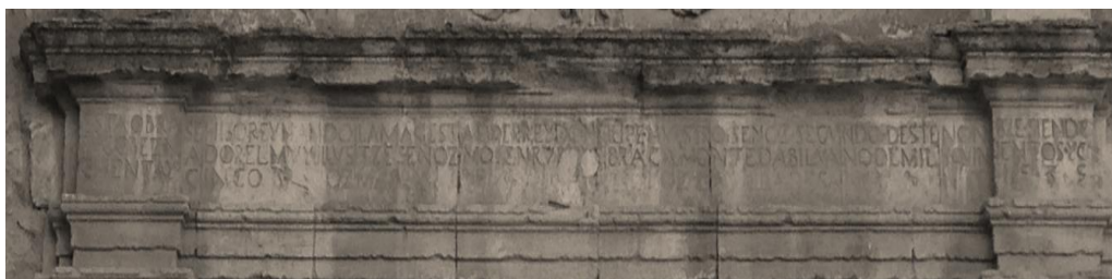
Foto 1. Detalle de la Cornisa del antiguo Pósito.
