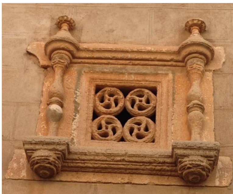
Fig. nº 25. Detalle de ventana con celosía, en calle del Marqués con Plaza de San Francisco. Siglo XVI.
