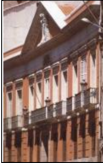
Fig. nº 80. Antiguo Edificio del Real Colegio de Farmacia de Madrid.
