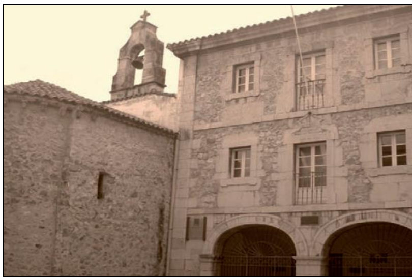
Fig. nº 127. Antiguo edificio del Hospital del Sancti Spiritus.
