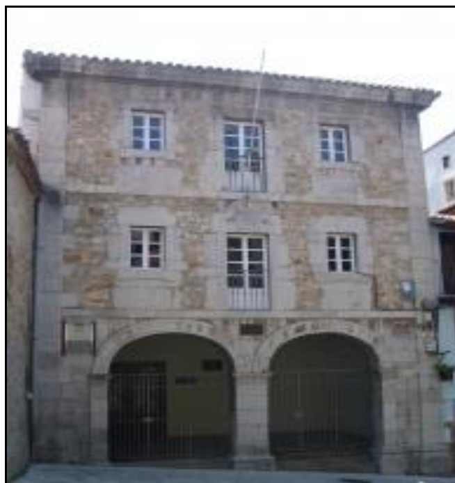
Fig. nº 125. Fachada principal del Antiguo Hospital de la Villa de Laredo.
