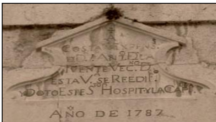
Fig. nº 122. Antiguo Hospital del Espíritu Santo. Reconstrucción de 1787.
