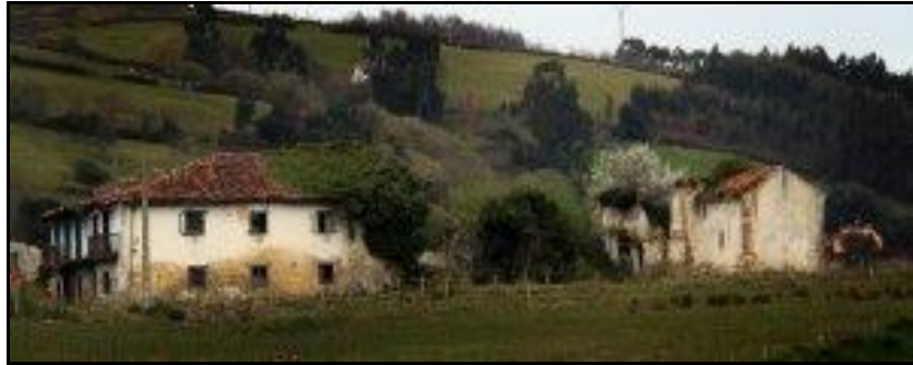
Fig. nº 115. Hospital-Lazareto de Abaño junto a la capilla de la antigua Ermita.
