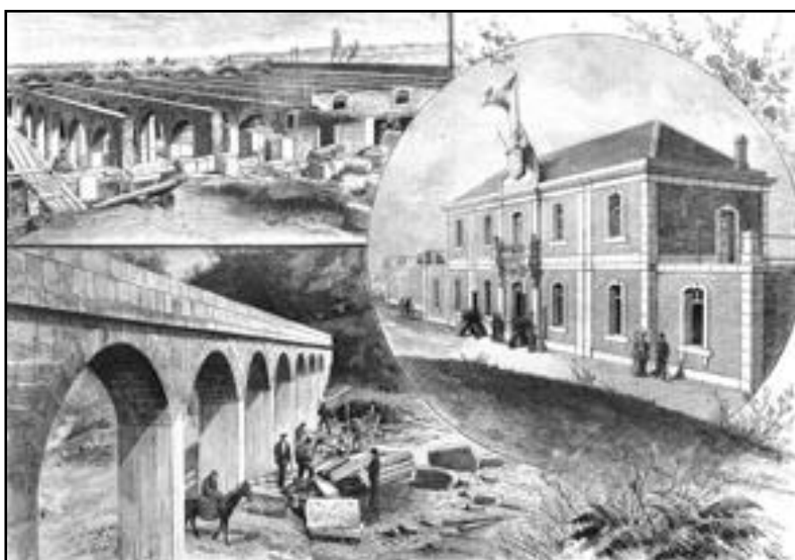
Fig. nº 155. Vistas de las Obras para la traída de Aguas de la Molina.
