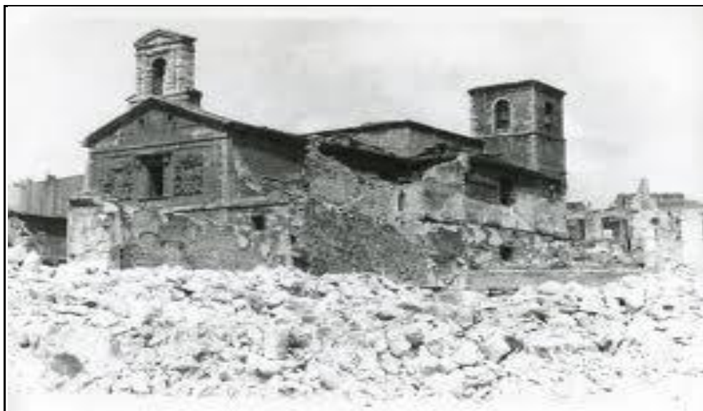
Fig. nº 406. Iglesia de la Compañía. Incendio de 1941.
