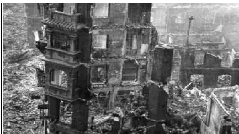
Fig. nº 377. Edificio en la confluencia de la Calle San Francisco y Calle Lealtad. Incendio de 1941.
