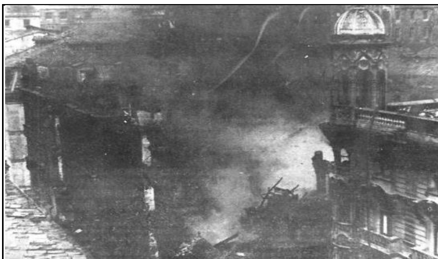
Fig. nº 421. Incendio en la Calle Hernán Cortés. 1941.
