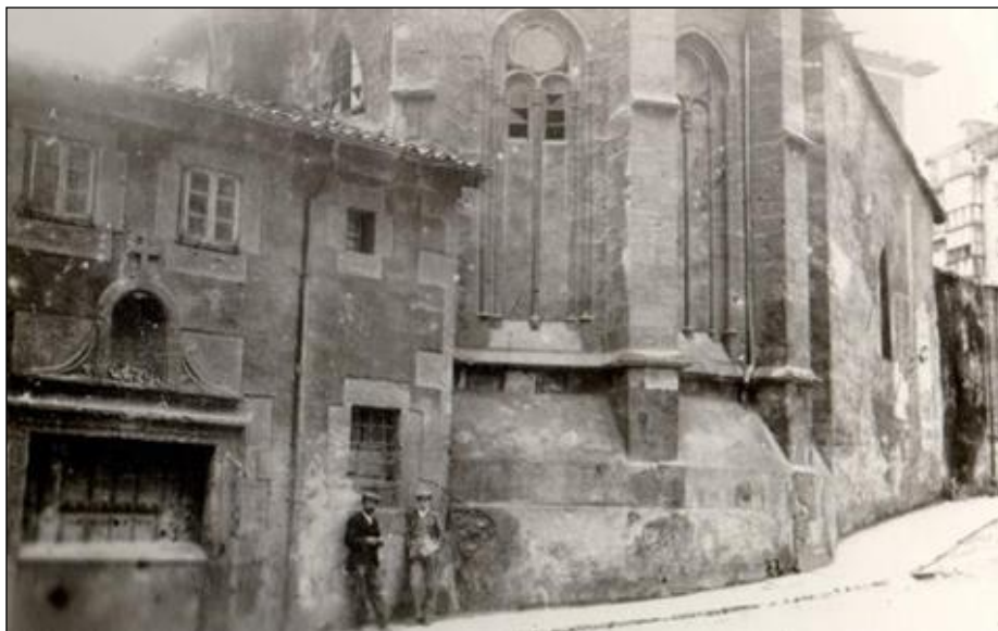
Fig. nº 20. Instituto, antes Convento de Santa Clara. Santander, 1890.
