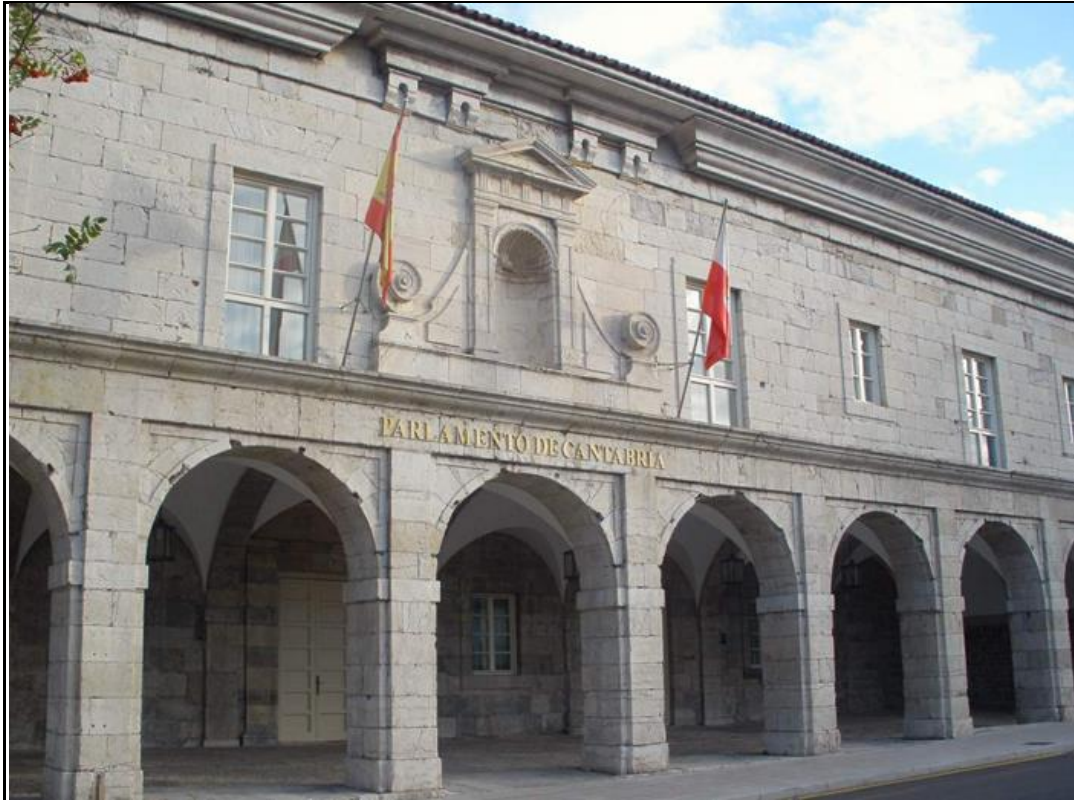
1 de 2. Fachada Principal. Antiguo Hospital de San Rafael.
