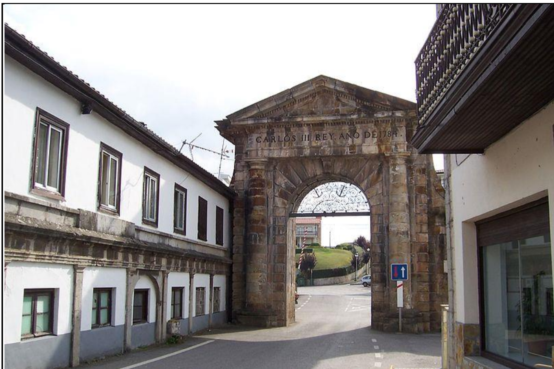
Fig. nº 25. La Cavada. Arco conmemorativo de 1784, hacia Carlos III, que daba entrada al recinto de las Reales Fábricas de Artillería.
