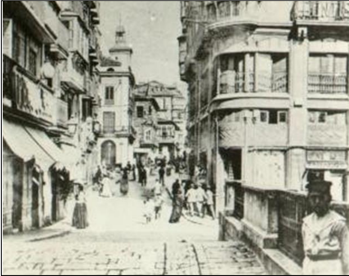
5 de 11. Plaza Vieja, 1905. Vista desde el Puente de Vargas.
