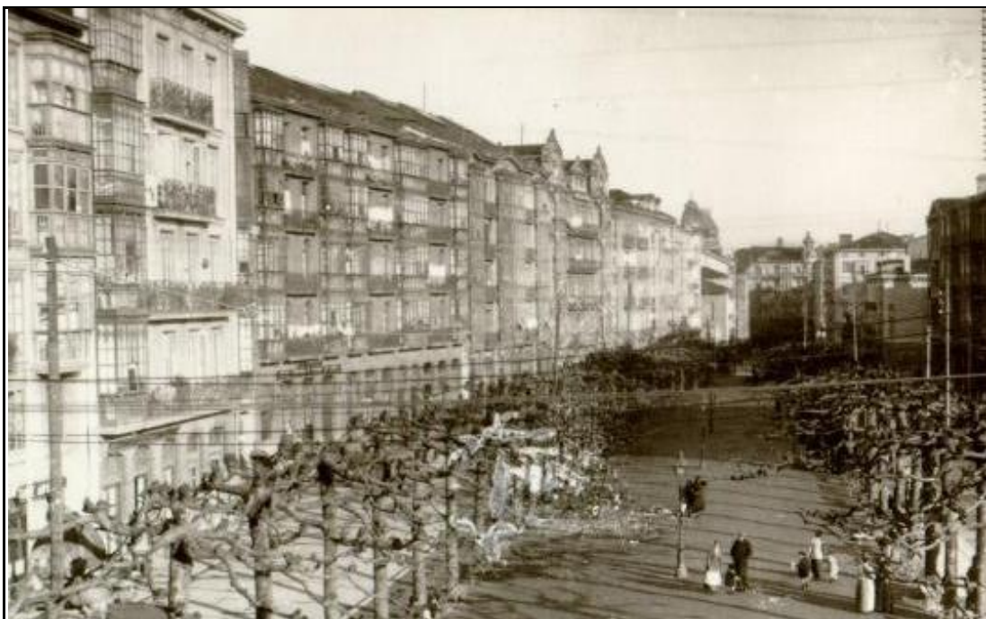
Fig. nº 186. Calle Alameda. Siglo XX.
