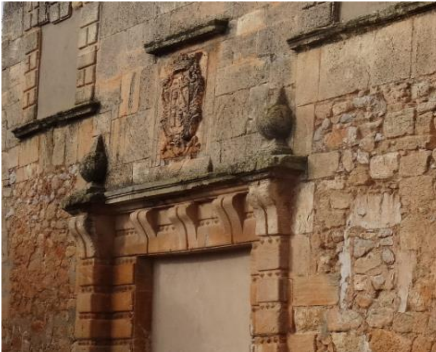
Foto 1. Casa-palacio de los Galindo-Tébar-Piquinotti. Fachada de piedra vista y de sillería.
