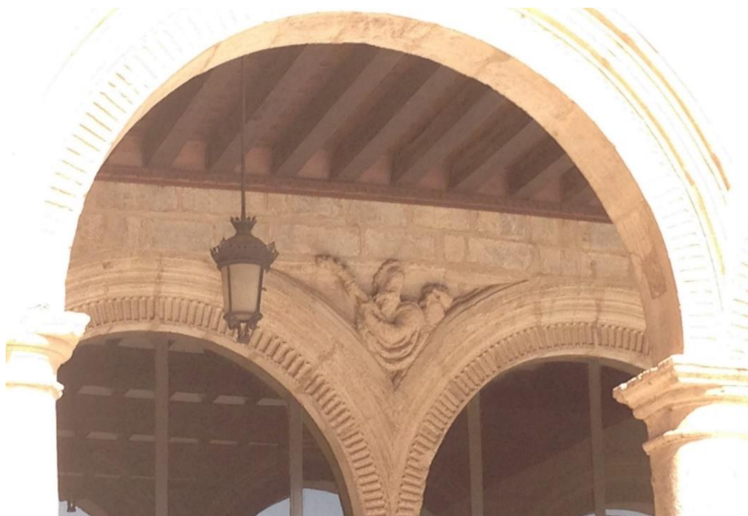
Fig. nº 78. Detalle de los soportales del Ayuntamiento. Siglo XVI.
