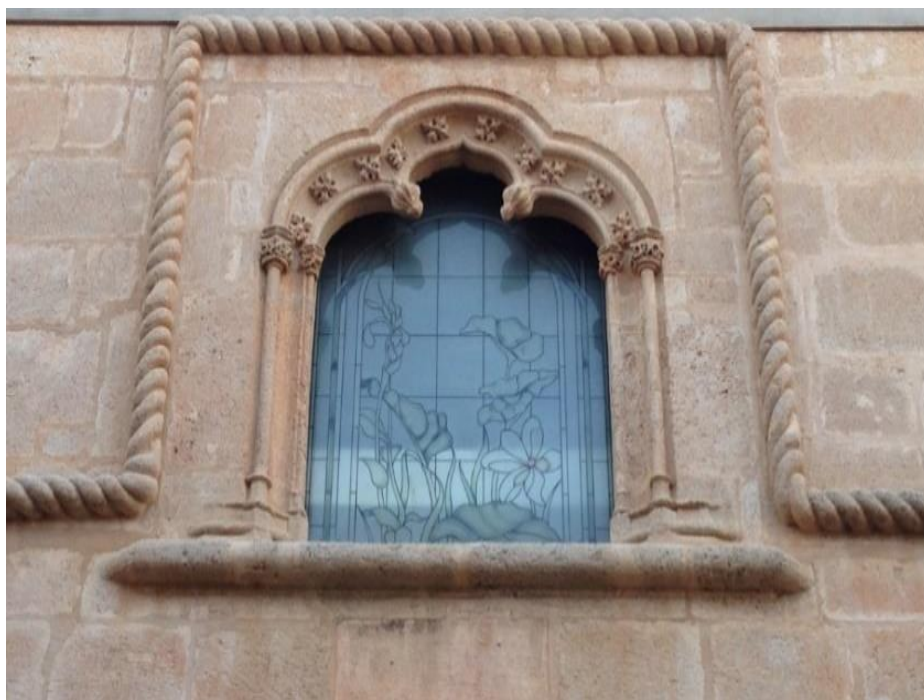
Fig. nº 83. Ventanas con remate de cordón sobre piedra labrada y ventana con arcos gótico-renacentistas. Siglo XVI.
