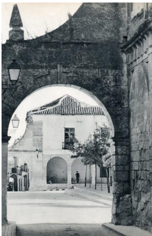
Fig. nº 119. Calle del Arco (con pináculo cuadrangular en punta).
