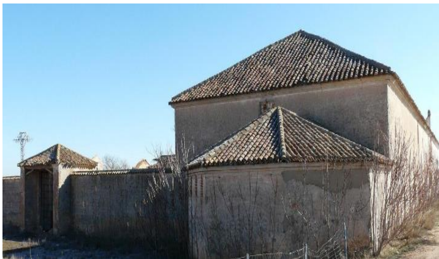
Fig. nº 74. Venta del Pinar, en el Camino Real de Madrid a Valencia.
