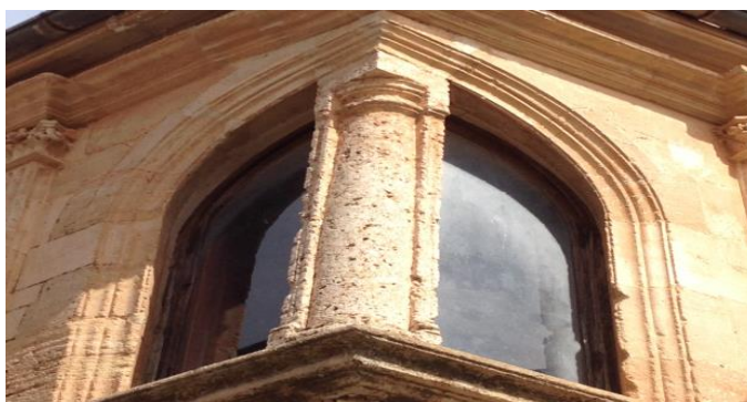
Fig. nº 92 . Calle de las Eras. Detalle de ventana, siglo XVI-XVII.
