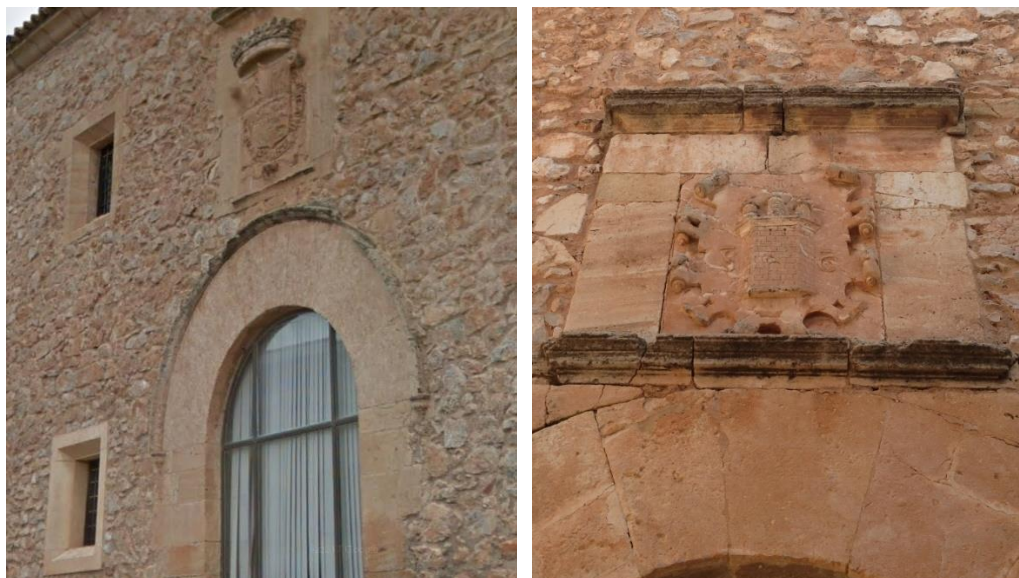
Fotos 2 y 3. Diversos escudos del edificio.
