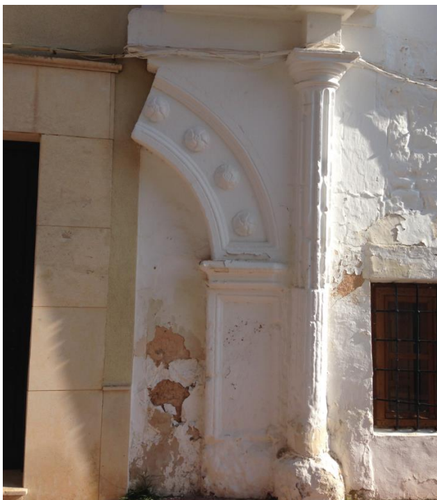
Fig. nº 72. Detalle de fachada en C/del Olmo, con elementos constructivos de los siglos XVI-XVII.
