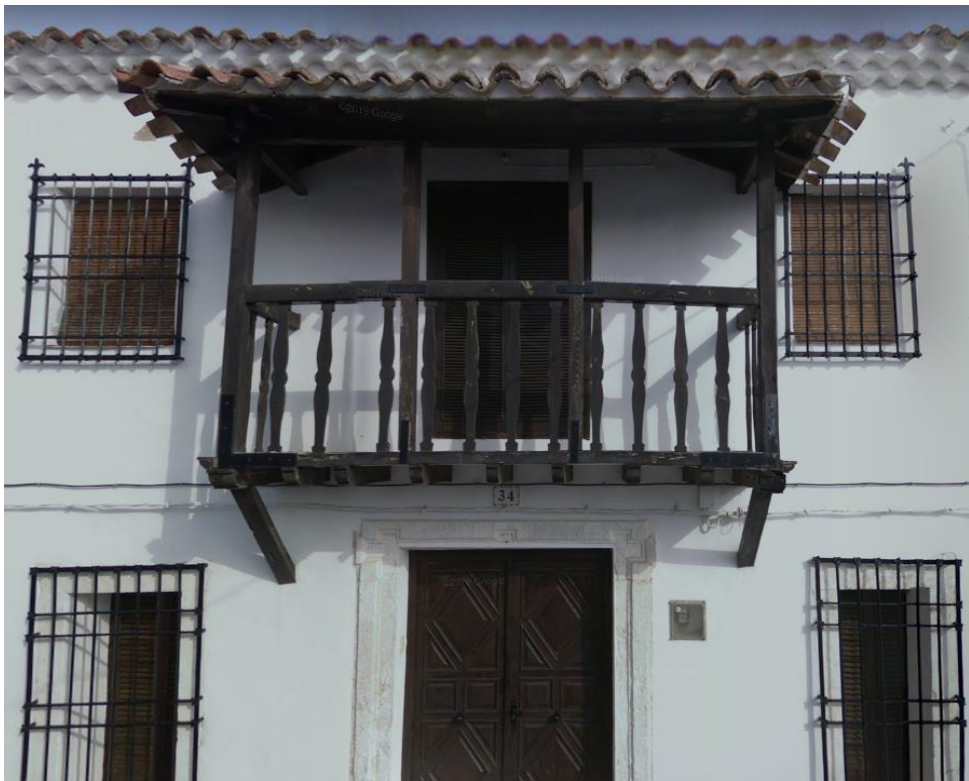
Fig. nº 200. Detalle de fachada, en Almodóvar del Pinar.
