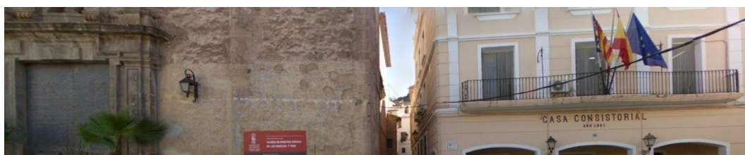
Fig. nº 405. Iglesia y Casa Consistorial de Tuéjar.
