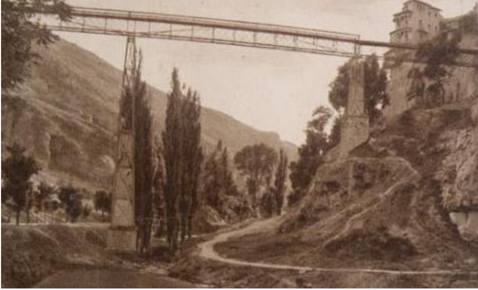
Foto 2. Puente de San Pablo y Casas Colgadas.
