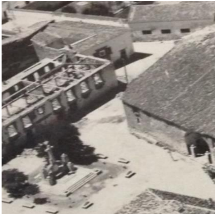
Foto 1. Se hacen obras en el antiguo edificio de la Cárcel (quitar tejado y construir segunda planta). Foto anterior a 1959 .
