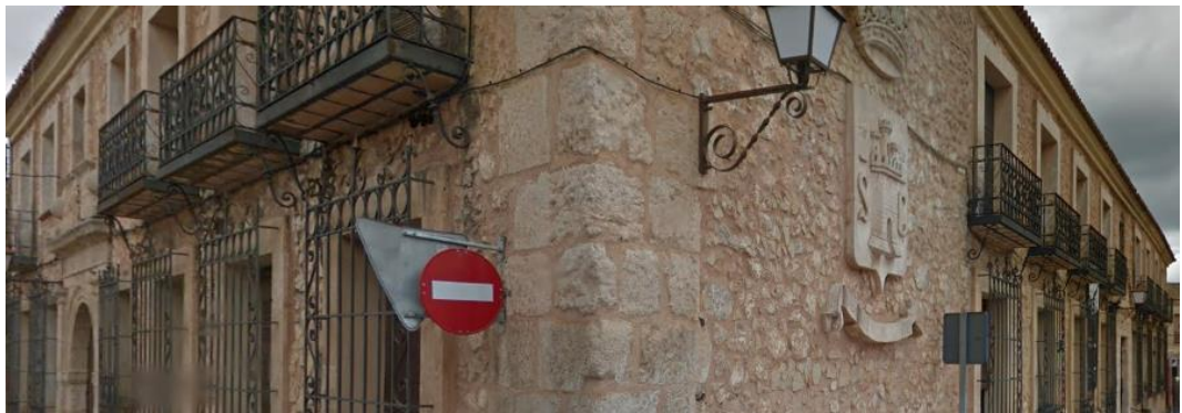
Foto 6. Se rehabilita, de nuevo la fachada, mostrando piedra vista.
