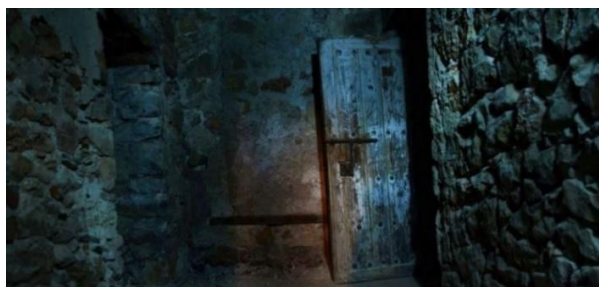
Fig. nº 507. Antigua cárcel en el edificio del Corregidor de Cuenca.
