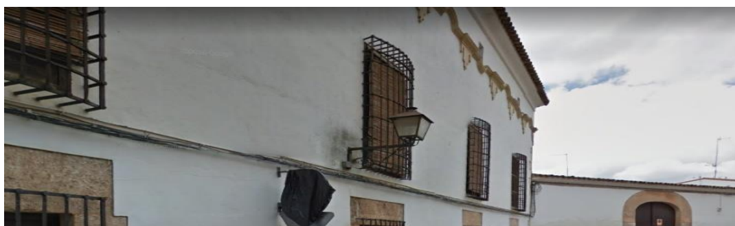
Fig. nº 7. Vista lateral, en calle del Pósito.
