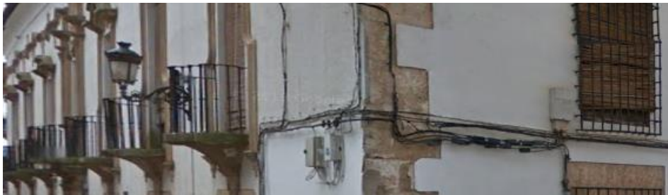
Fig. nº 6. Vista lateral de la Casa-palacio de Oma.
