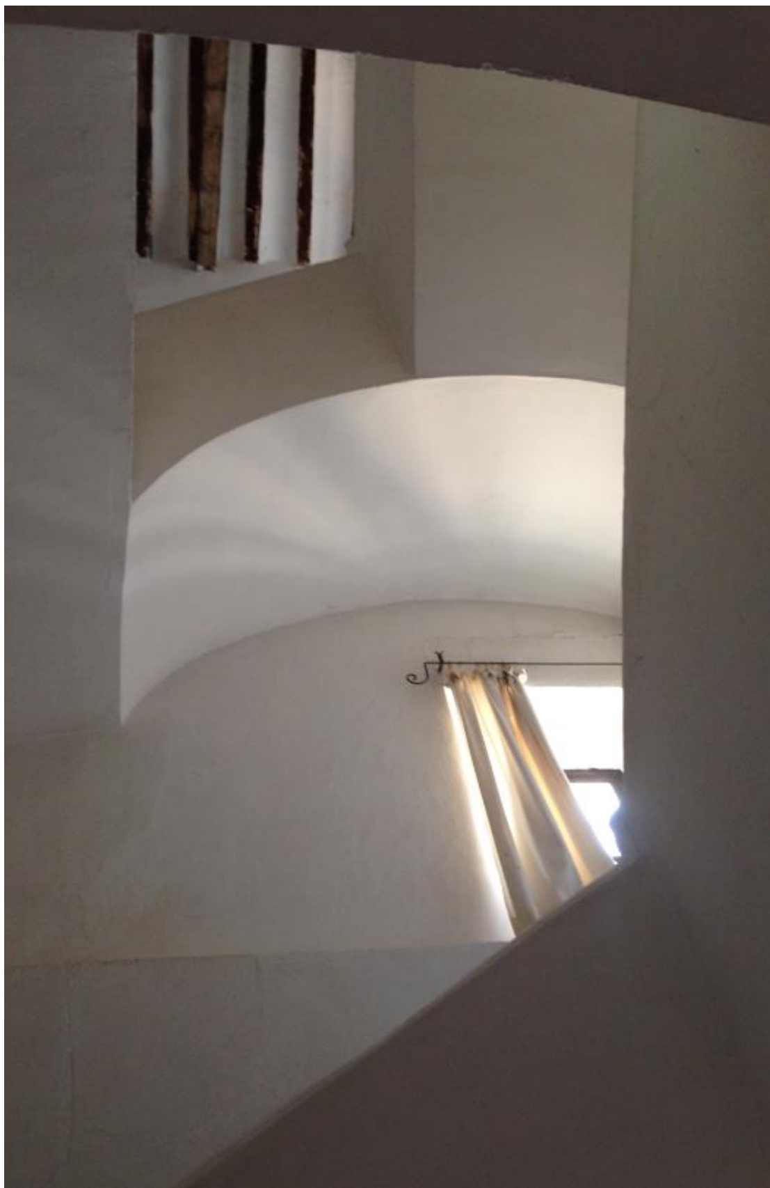
Foto 17. Escalera de subida a las cámaras.
