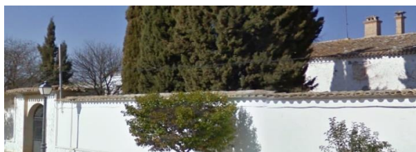
Fig. nº 99. Vista de la Casa principal de la antigua alquería de los Jesuitas de San Clemente (siglos XVII y XVIII),
