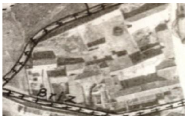
Fig. nº 21. Localización de la Alquería de los Jesuitas o Teatinos , en 1620, entre las actuales calles Diagonal y de los Pinos con el Paseo de las Acacias.
