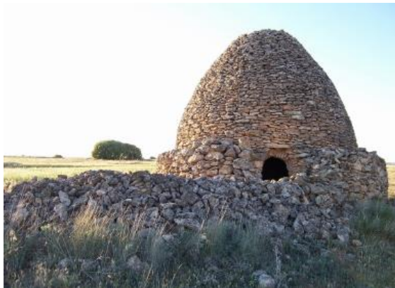
Fig. nº 1. Cubillo en la carretera de Casas de Fernando Alonso a Minaya, de varios metros de altura.
