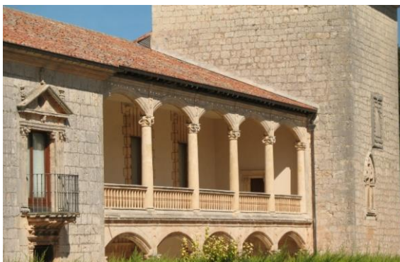
Vista lateral del Palacio de Saldañuela (foto, fuente: Wikipedia).
